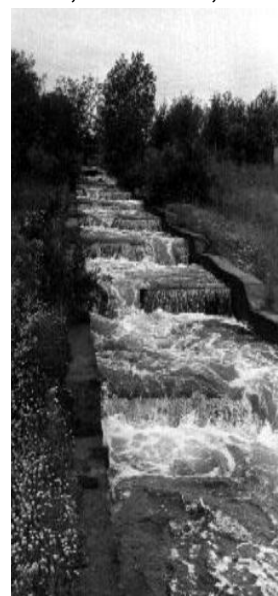
Рибохід для пропуску на нерест сьомги і горбуші на Нижньо-Тулумской ГЕС
