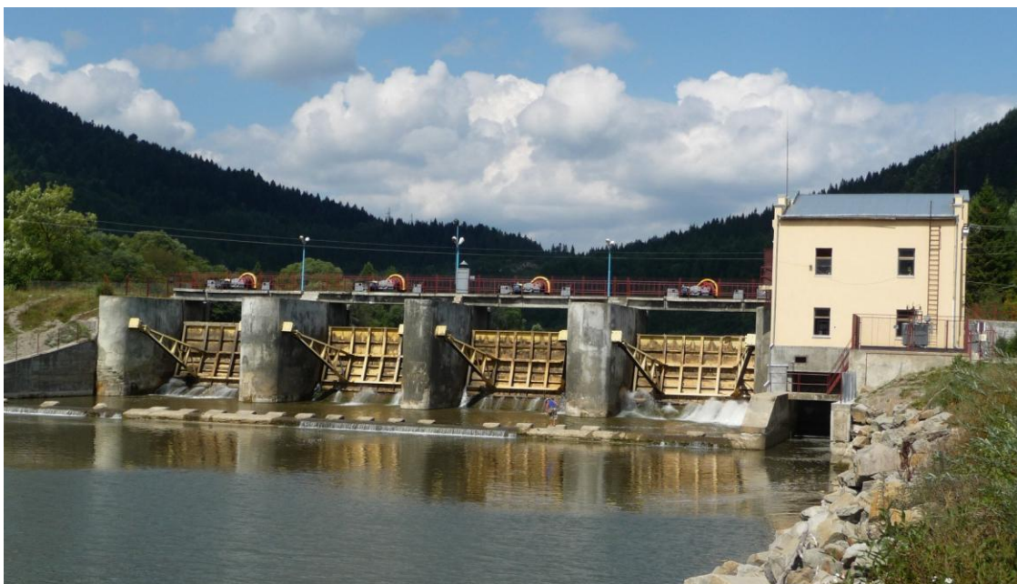
Рис. 2.7 - Руслова гідроелектростанція 24 (Яворська мала ГЕС, Львівська обл., р. Стрий потужність 450 кВт)
