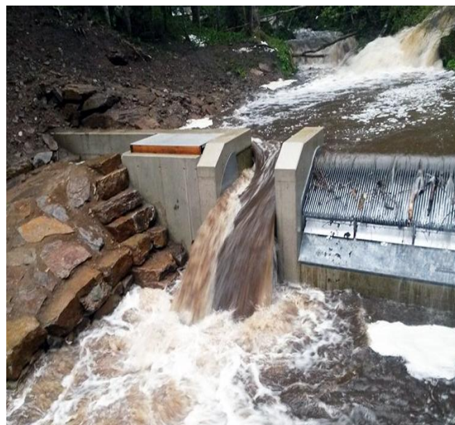
Рис. 4.3 – Система решіток «Grizzly Power» 85
